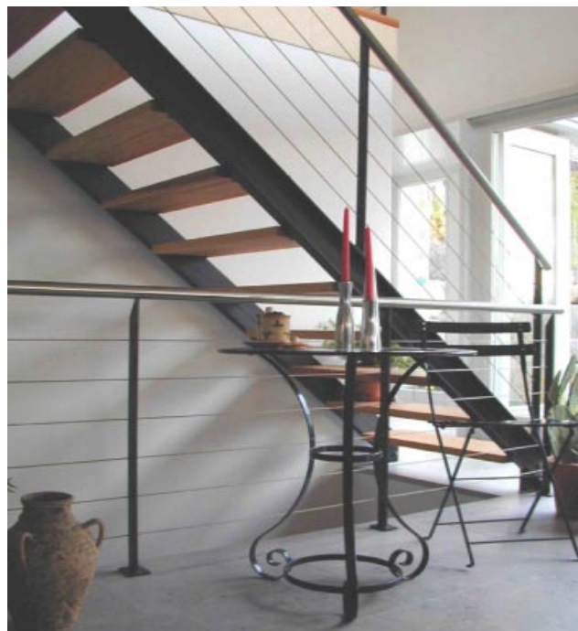
Stahlterasse mit Holztritten, Geländer mit Handlauf aus Chrom-Nickel-Stahl Firma W. Suter AG Metallhandwerk, Muttenz
